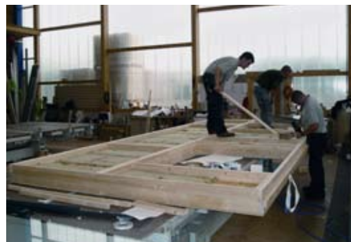
Строительство по каркасно-панельной технологии.
