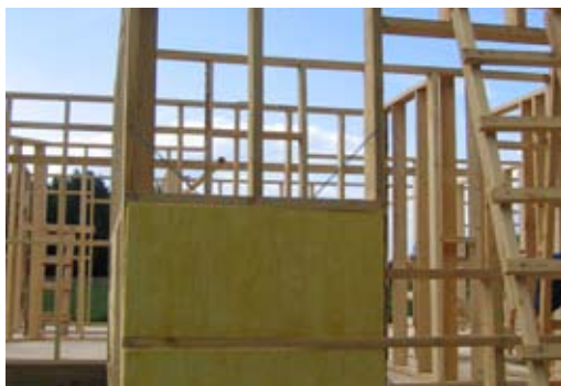
Строительство по каркасно-рамочной технологии.
