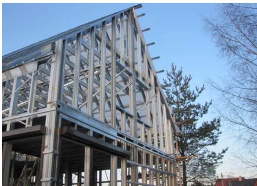
Жилое здание из ЛСТК (производитель – ООО «Балтпрофиль»).
