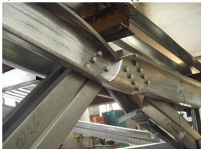
Каркасы зданий из ЛСТК очень чувствительны к локальным нагрузкам – при небольшом превышении постоянной нагрузки, тонкий металл в местах крепления рвется, что благодаря большому числу связей и чувствительности к локальным воздействиям связанных узлов приводит к обрушению всего здания.
