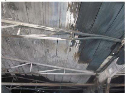
Для безопасной эксплуатации зданий необходима дорогостоящая окраска металлических конструкций специальным огнезащитным составом. Без качественной огнезащиты при пожаре здание из ЛСТК потеряет устойчивость и разрушится значительно быстрее, чем здание из ЛМК.
